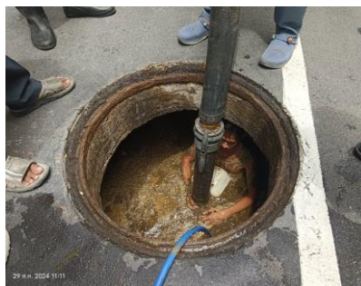
รูปที่ 2-17 สูบไขมันและสิ่งปฏิกูล เมื่อวันที่ 29 สิงหาคม 2567 และในปี 2568 มีแผนในเดือนสิงหาคม
