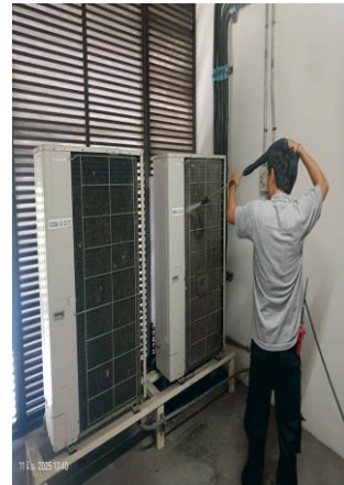
รูปที่ 2-28 เจ้าหน้าที่ทำความสะอาดแอร์ส่วนกลาง
