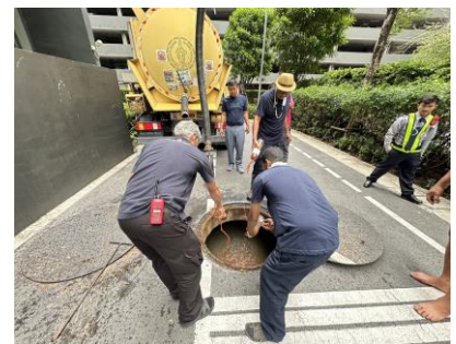
รูปที่ 2-17 สูบไขมันและสิ่งปฏิกูล เมื่อวันที่ 29 สิงหาคม 2567 และในปี 2568 มีแผนในเดือนสิงหาคม
